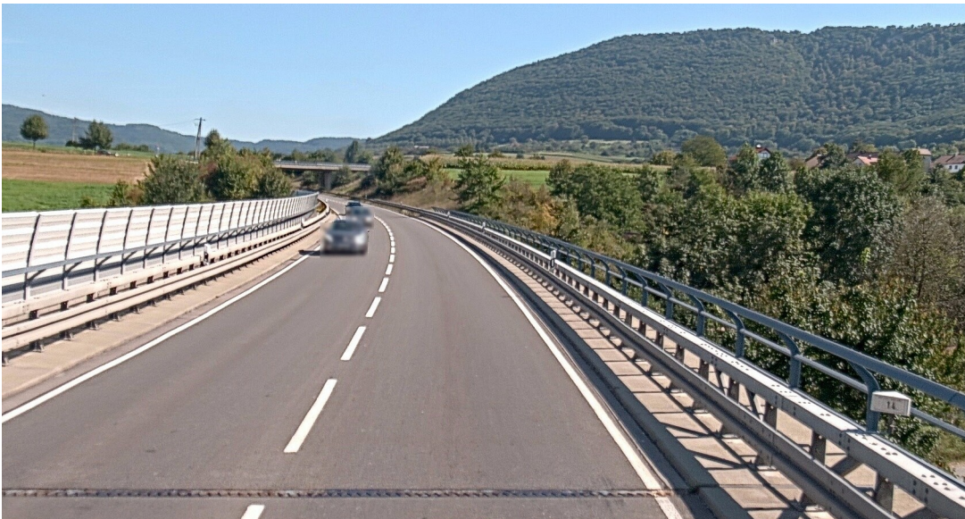
B 28 Glemsbachtalbrücke Blickrichtung Bad Urach
