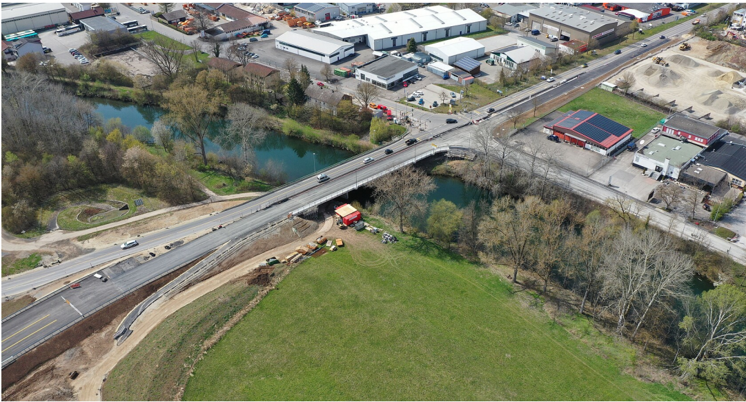
Neckarbrücke Rottenburg Blickrichtung Nordwesten
