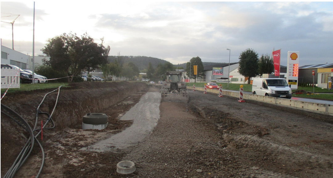
B 28 Osttangente Rottenburg - Ausbau zwischen Schuhstrasse und Siebenlindenstrasse
