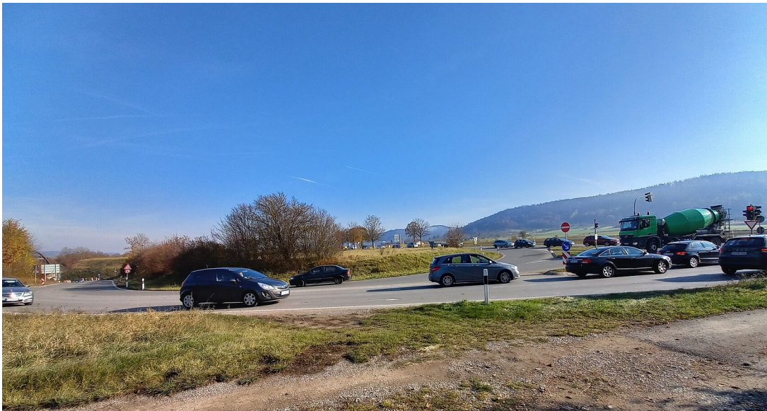
B 28 Rottenburg - Tübingen | Baumfäll- und Rodungsarbeiten im Bereich L 361 / L 370 / L 385 beim Knoten Rottenburg Ost
