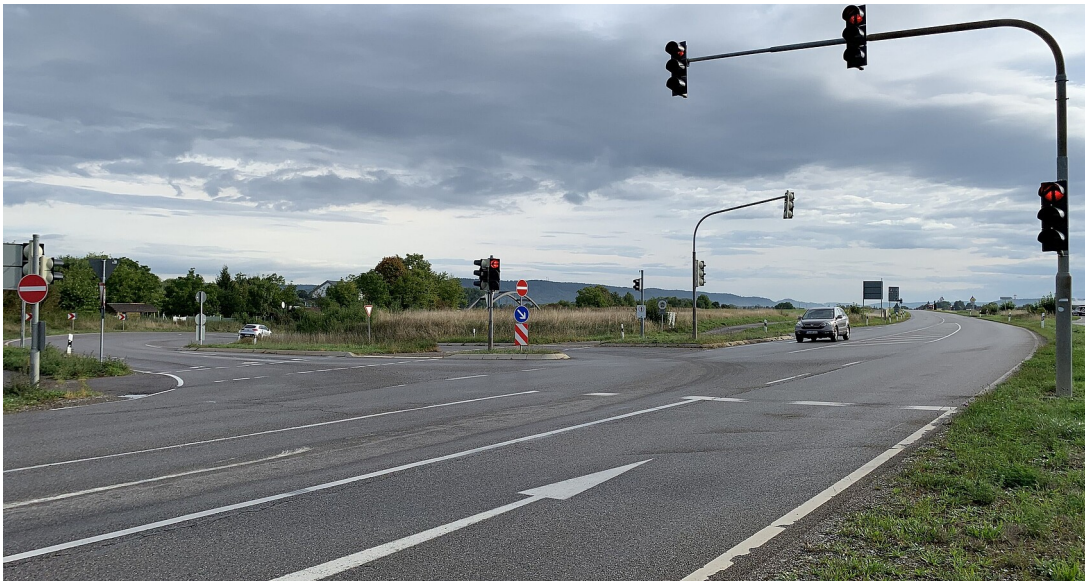
L 370 in Fahrtrichtung Rottenburg-Kiebingen
