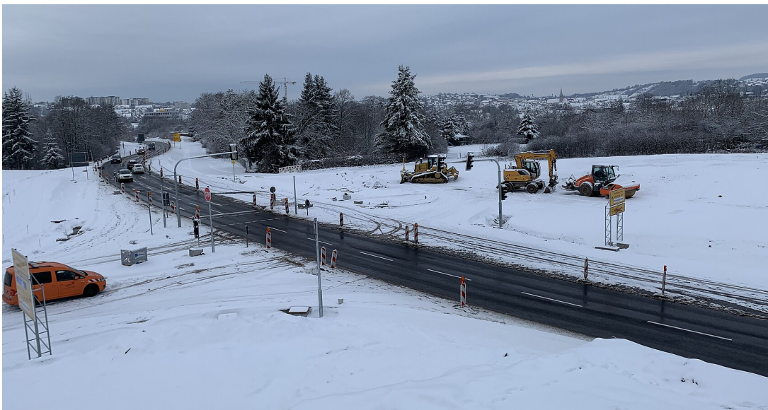
Umbauarbeiten am Anschluss Rottenburg-Kiebingen im Zuge des Neubaus der B 28 Rottenburg-Tübingen
