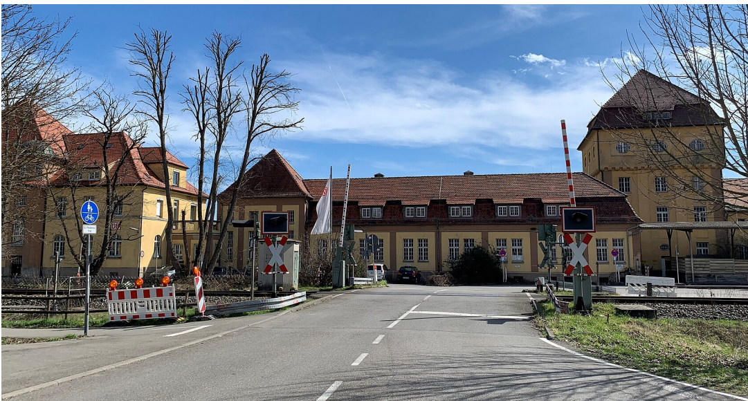
Bahnübergang an der Bahnstrecke Tübingen-Rottenburg auf Höhe der B 28
