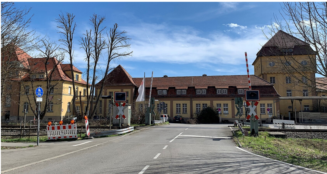
Bahnübergang an der Bahnstrecke Tübingen-Rottenburg auf Höhe der B 28
