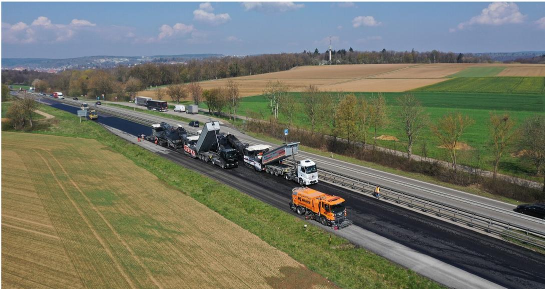
Fahrbahndeckenerneuerung zwischen Tübingen und Reutlingen - Einbauzug fuer den Kompaktasphalt
