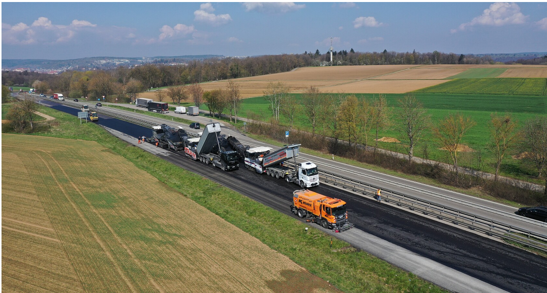
Fahrbahndeckenerneuerung zwischen Tübingen und Reutlingen - Einbauzug fuer den Kompaktasphalt
