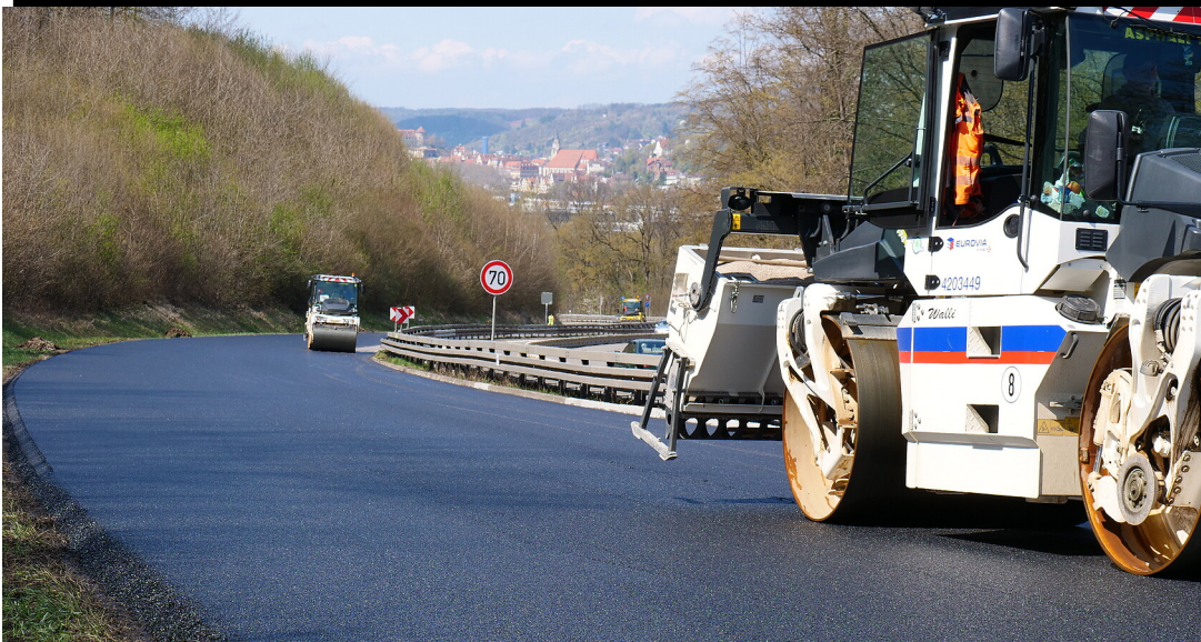
Fahrbahndeckenerneuerung zwischen Tübingen und Reutlingen
