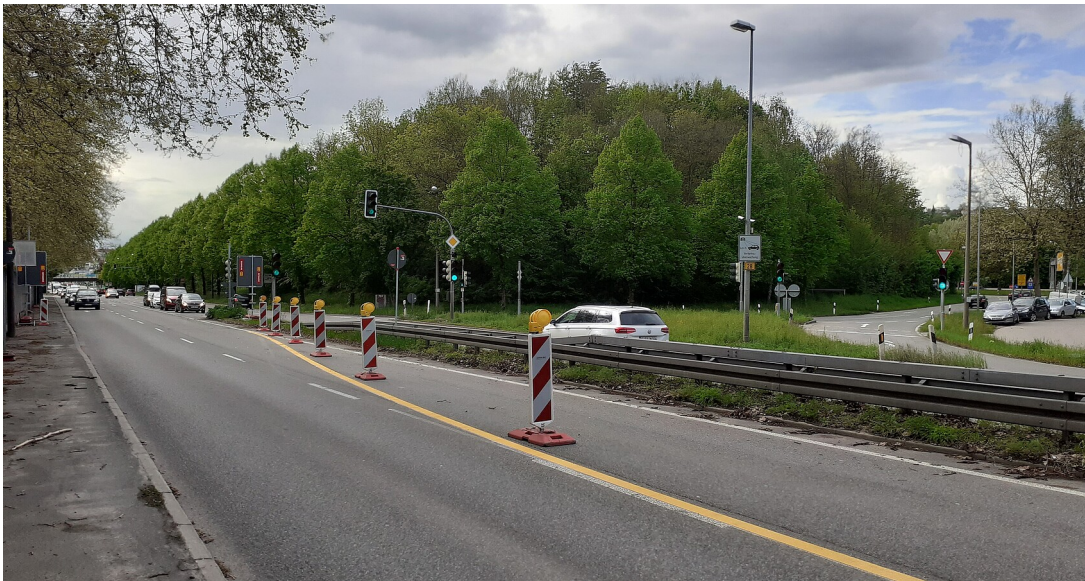
B 28 Ortseingang Tübingen, in dem die Bauarbeiten in den Pfingstferien stattfinden
