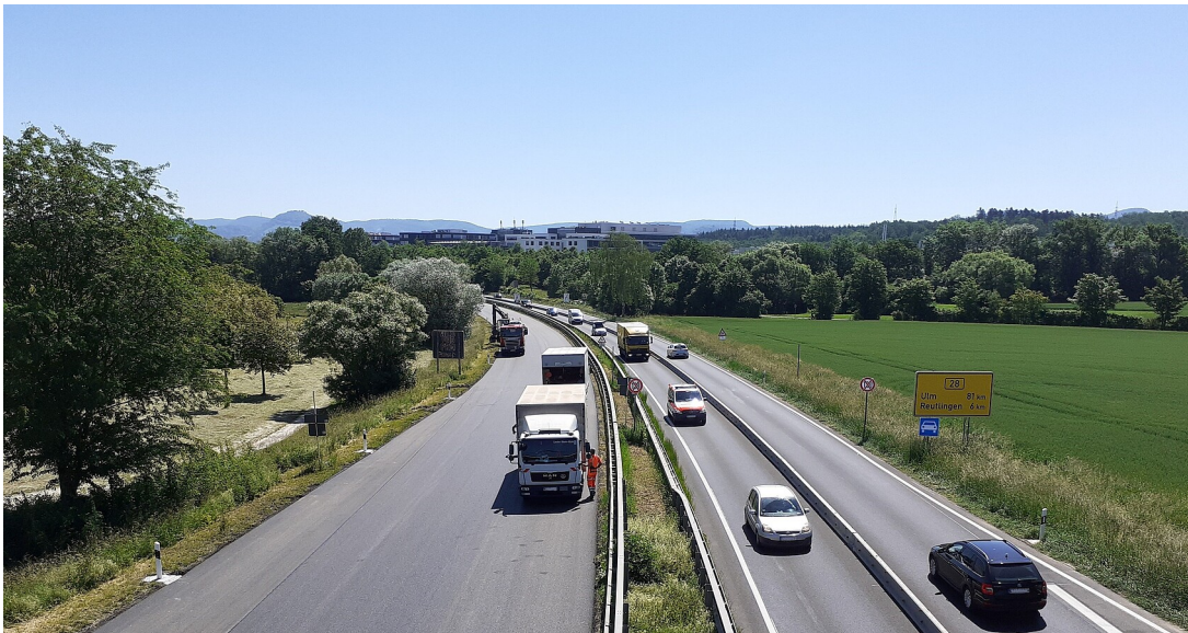
B 28 zwischen der Ortsdurchfahrt von Tübingen und der Anschlussstelle Jettenburg
