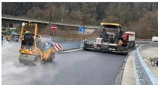
Sanierungsarbeiten an der B 30 Anschlussstelle Ravensburg Nord
