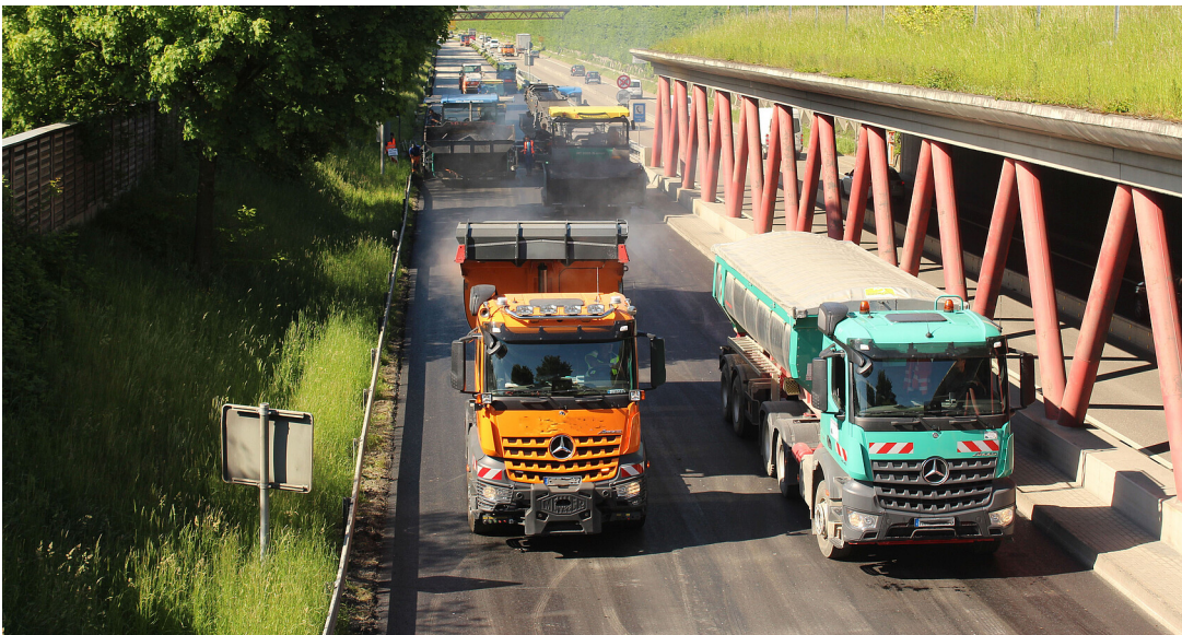
Fahrbahndeckenerneuerung auf der B 30 Ortsumfahrung Ravensburg
