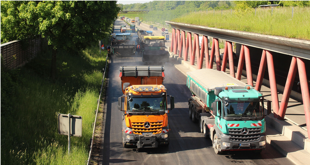
Fahrbahndeckenerneuerung auf der B 30 Ortsumfahrung Ravensburg
