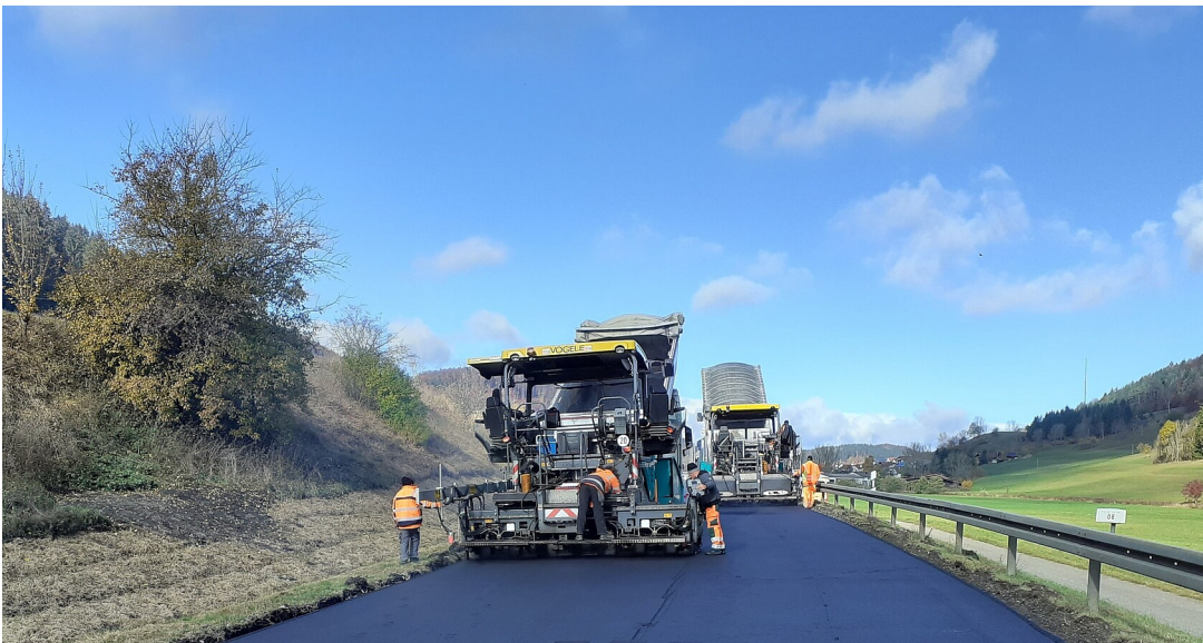
Symbolbild für eine Straßensanierung
