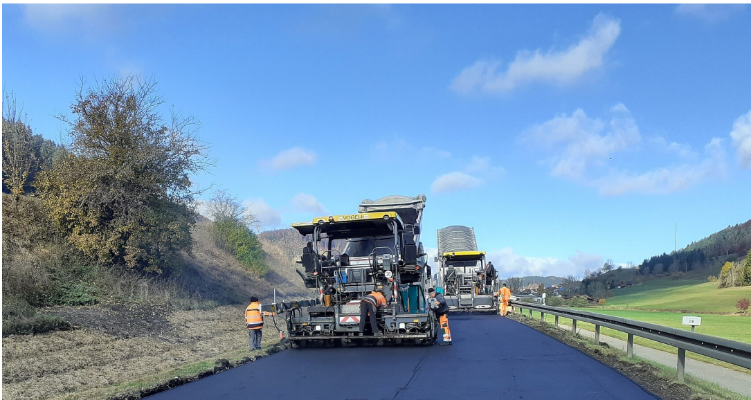
Symbolbild für eine Straßensanierung
