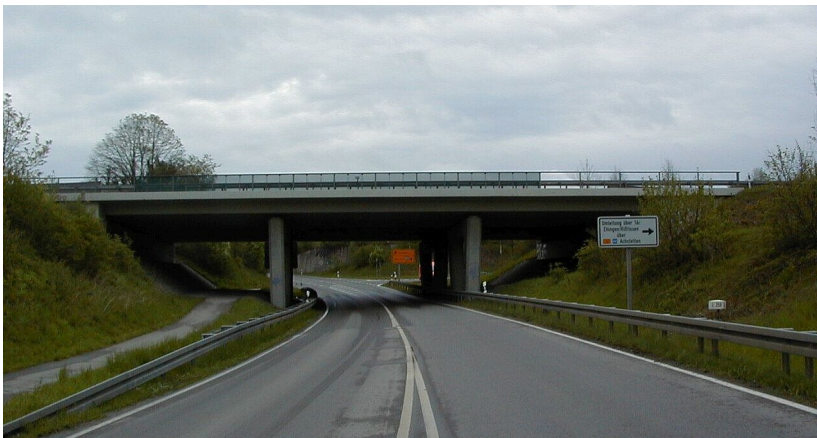
Brücke über die L 259 bei Laupheim-Mitte in Fahrtrichtung Ulm-Biberach
