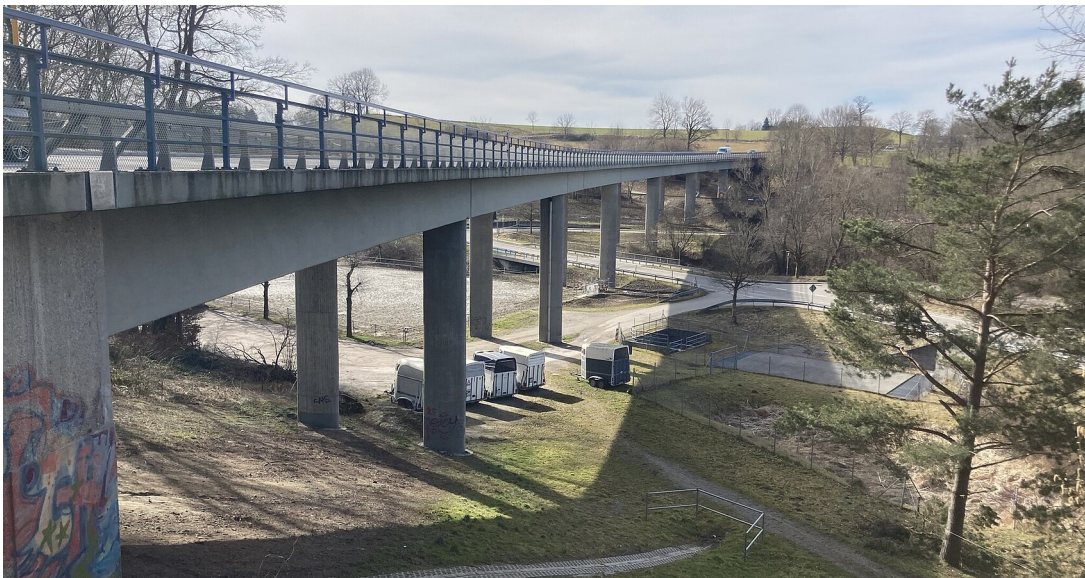
Urbachviadukt in Blickrichtung Süd-West
