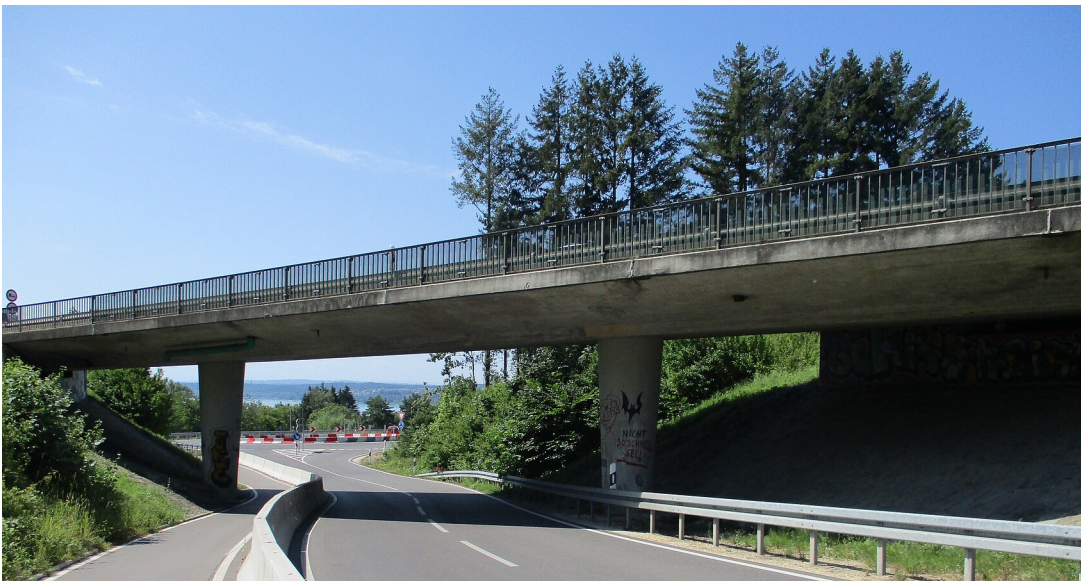
Brücke über die Rengoldshauerstrasse
