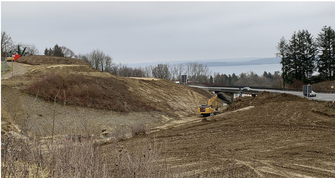
Bauarbeiten an der Anschlussstelle Rengoldshauser Straße bei Überlingen
