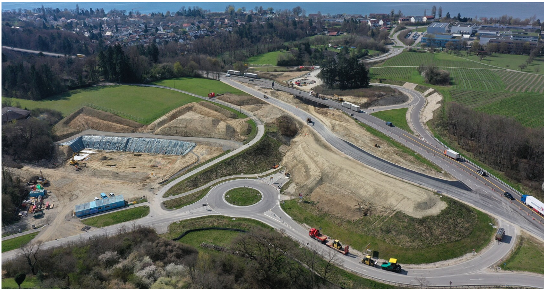
Luftaufnahme von der Baustelle Anschluss der Rengoldshauer Straße bei Überlingen-Altbirnau
