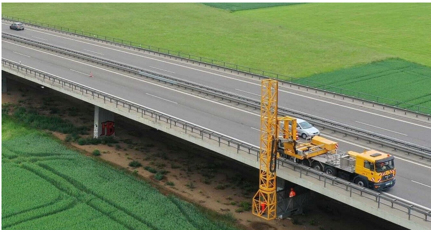
Brückenuntersichtgerät während der Arbeit
