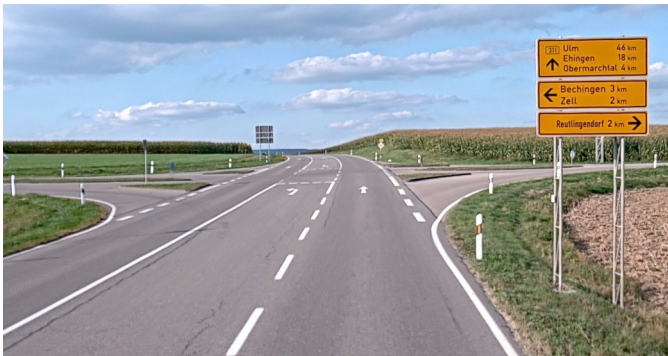
Bundesstraße 311 zwischen Unlingen und Obermarchtal
