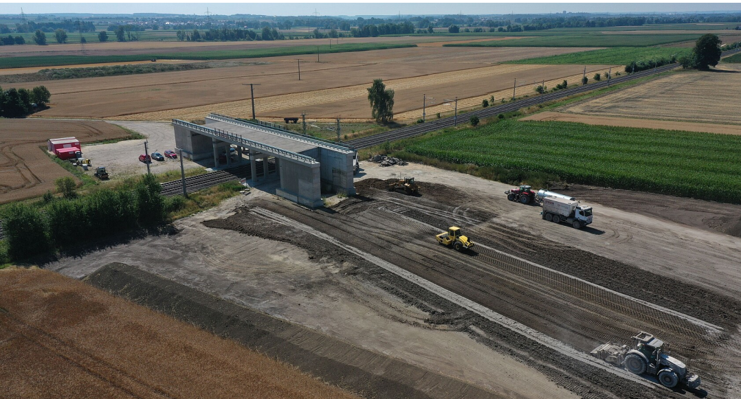
Luftbild von der Baustelle an der B 311 Querspange zur B 30 bei Erbach
