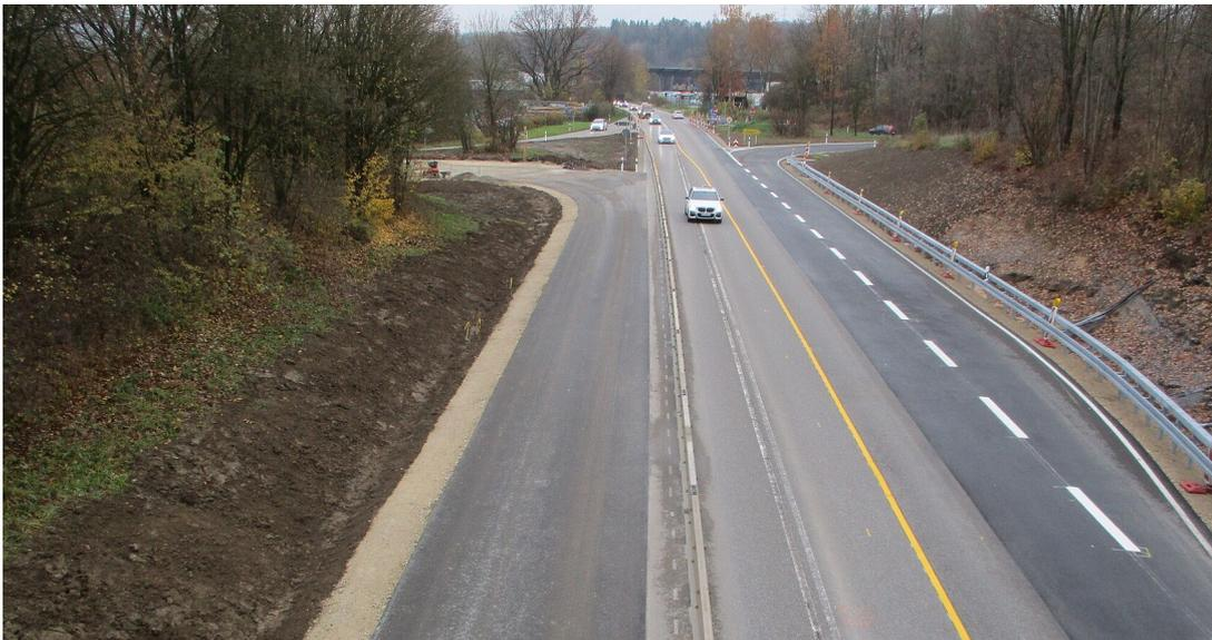
Einfädelungstreifen auf der B 312 an der Anschlussstelle der L 374 bei Riederich
