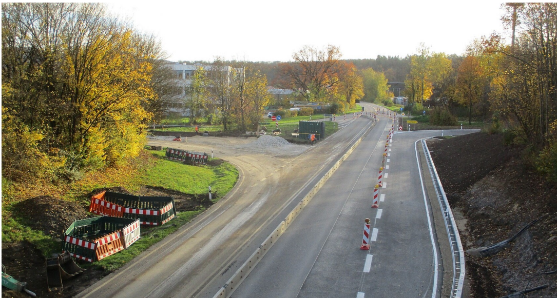
B 312 an der Anschlussstelle der L 374 bei Riederich
