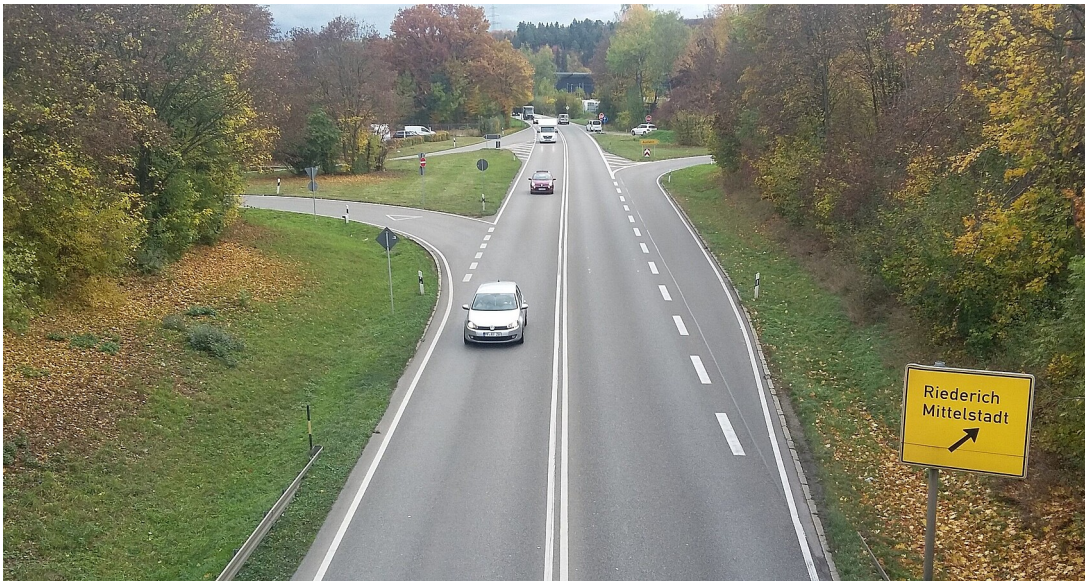
B 312 auf Höhe der Anschlussstelle Riederich
