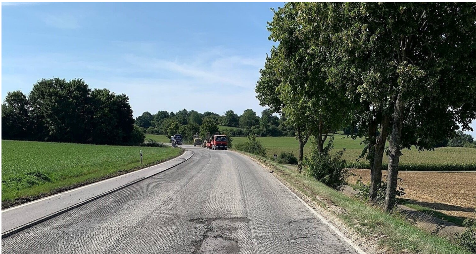
Fahrbahndeckenerneuerung B 312 zwischen Hohenstein-Bernloch und Pfronstetten-Huldstetten
