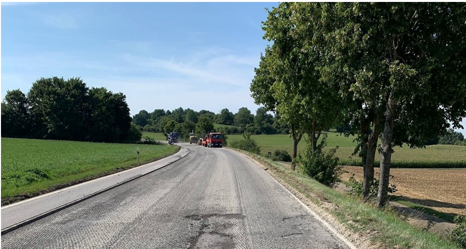
Fahrbahndeckenerneuerung B 312 zwischen Hohenstein-Bernloch und Pfronstetten-Huldstetten
