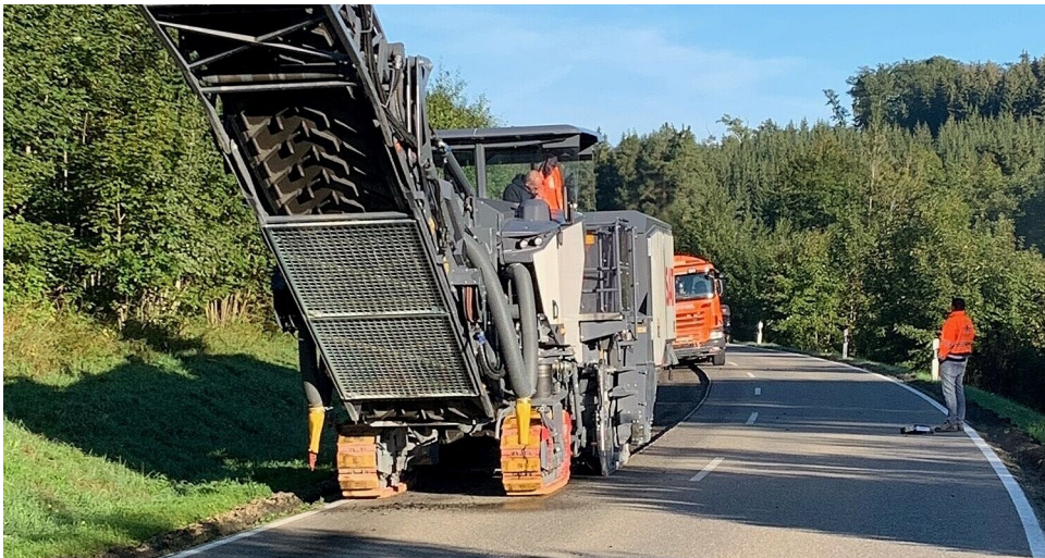
Belagsarbeiten an der B 312
