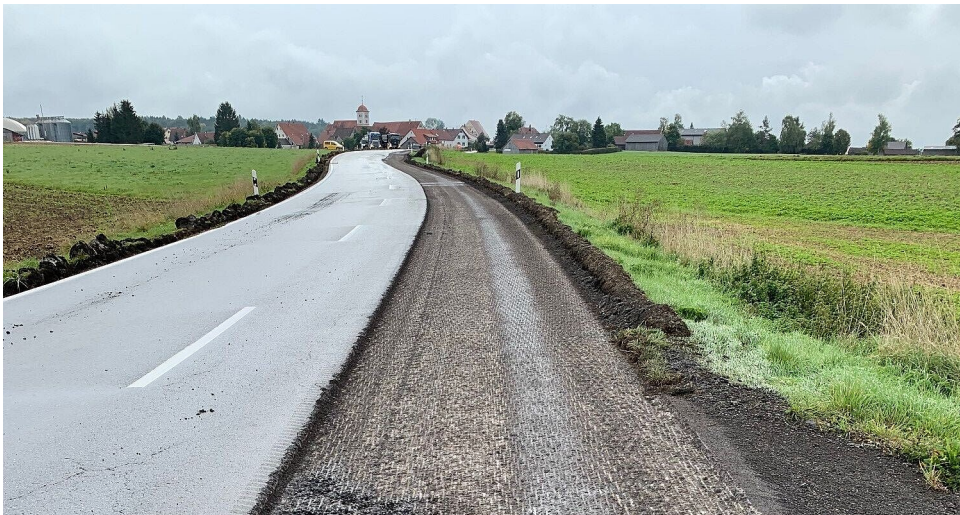
Fahrbahndeckenerneuerung auf der B 312 zwischen Hohenstein-Bernloch und Pfronstetten-Huldstetten in Höhe Tigerfeld
