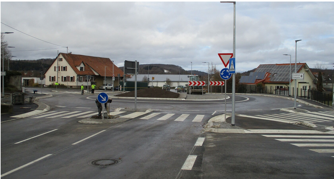
Neubau Kreisverkehr Kleinengstingen
