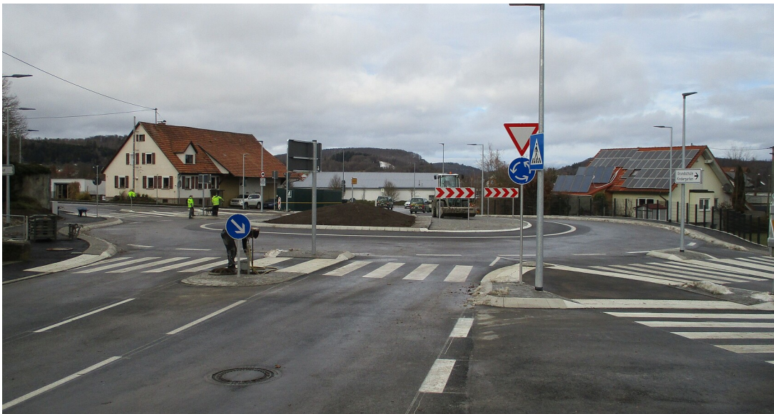
Neubau Kreisverkehr Kleinengstingen
