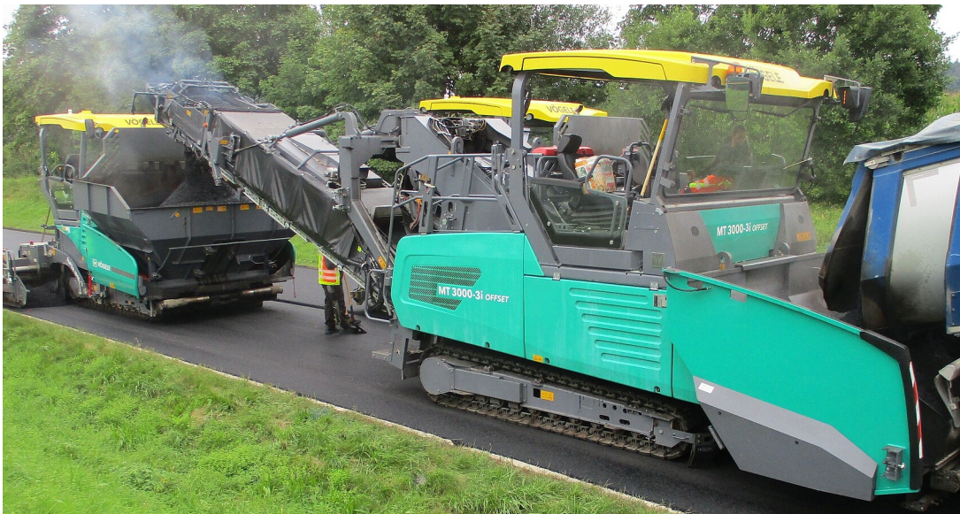
Fahrbahndeckenerneuerung auf der B 312
