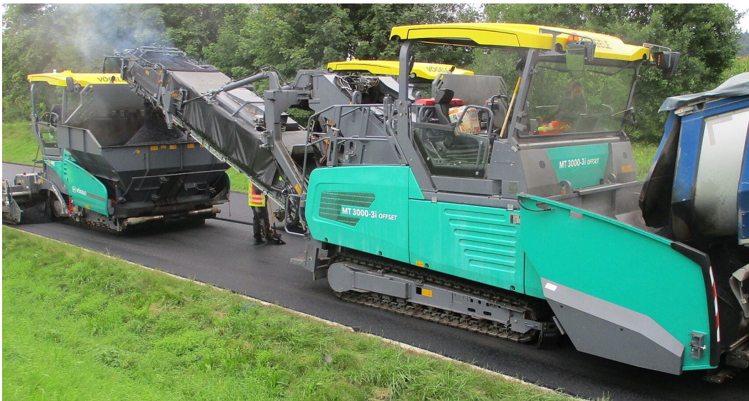
Fahrbahndeckenerneuerung auf der B 312
