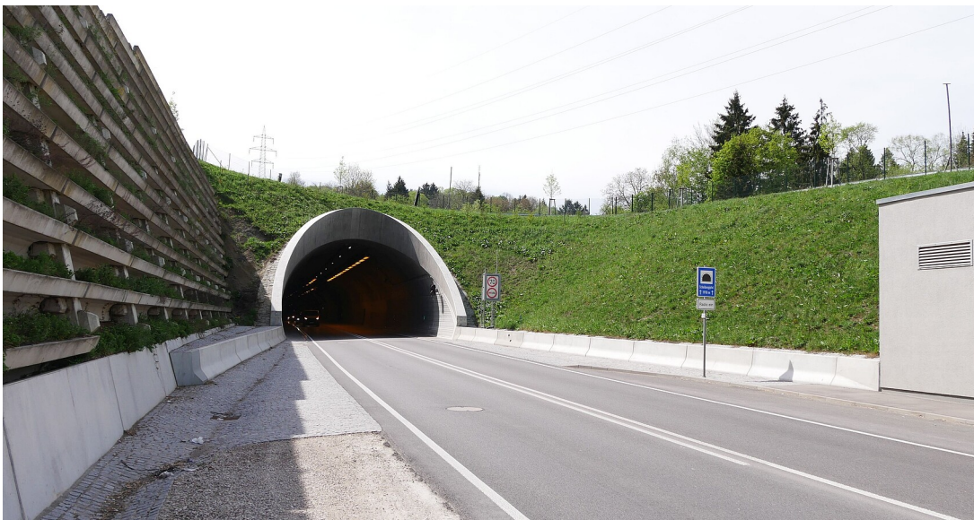
Nordportal des Scheibengipfeltunnels
