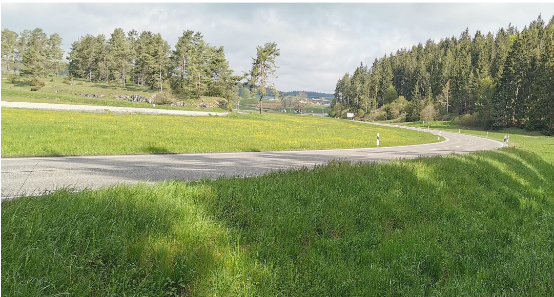
Fahrbahn der B 313 zwischen Trochtelfingen und der Haid
