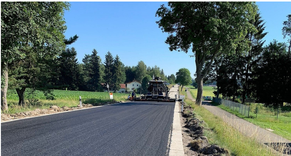
Straßenbauarbeiten auf der B 313 bei Engstingen-Haid
