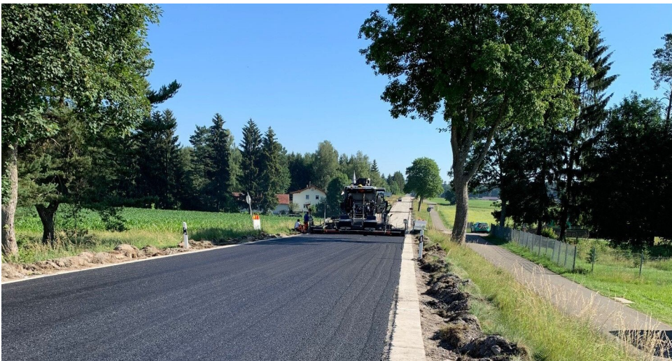
Straßenbauarbeiten auf der B 313 bei Engstingen-Haid
