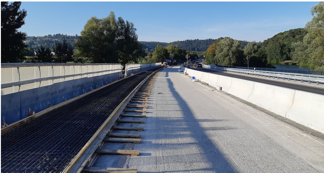
Baustelle auf der Donaubrücke Sigmaringen
