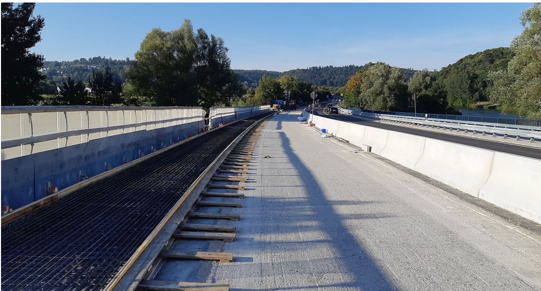
Baustelle auf der Donaubrücke Sigmaringen
