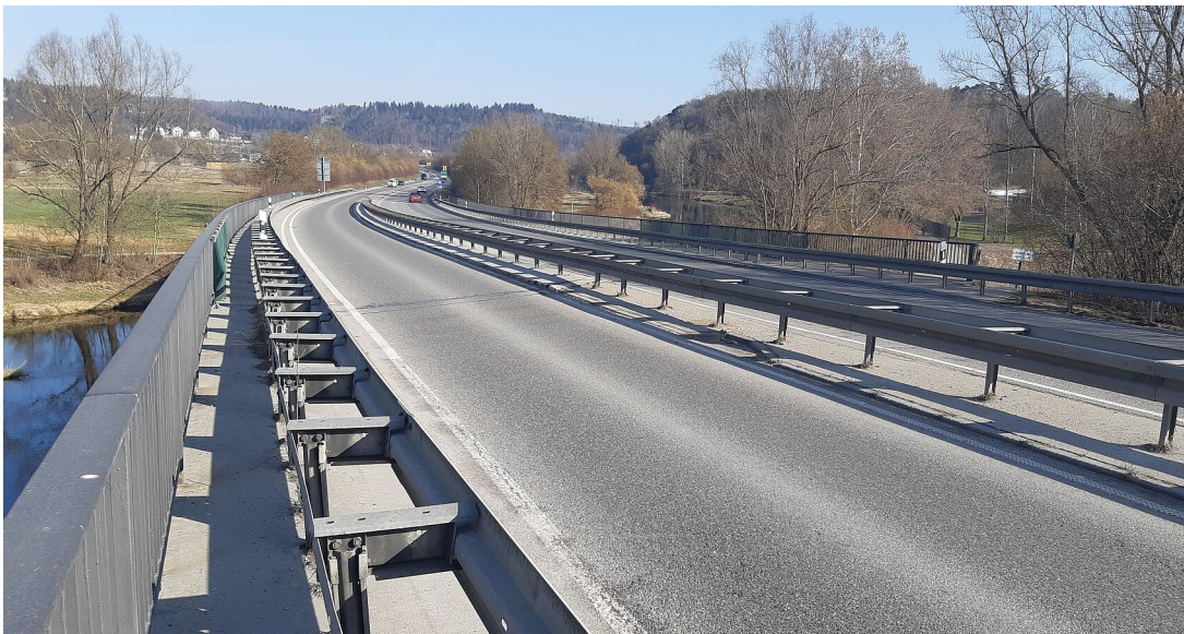
Brücke über die Donau mit Blickrichtung Sigmaringen
