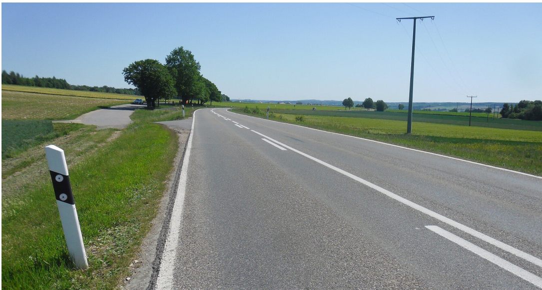
B 313 Kurve im Bereich des Parkplatzes zwischen Vilsingen und Inzigkofen
