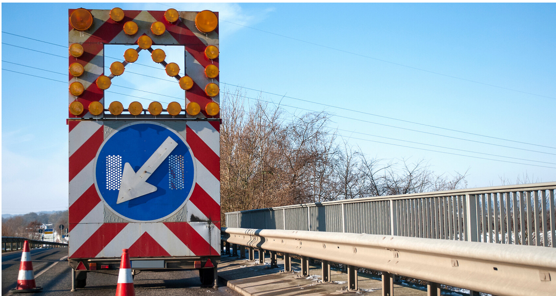
Baustelle auf einer Brücke
