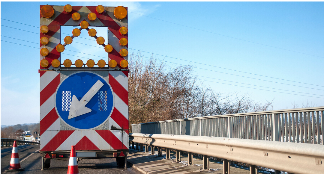
Baustelle auf einer Brücke
