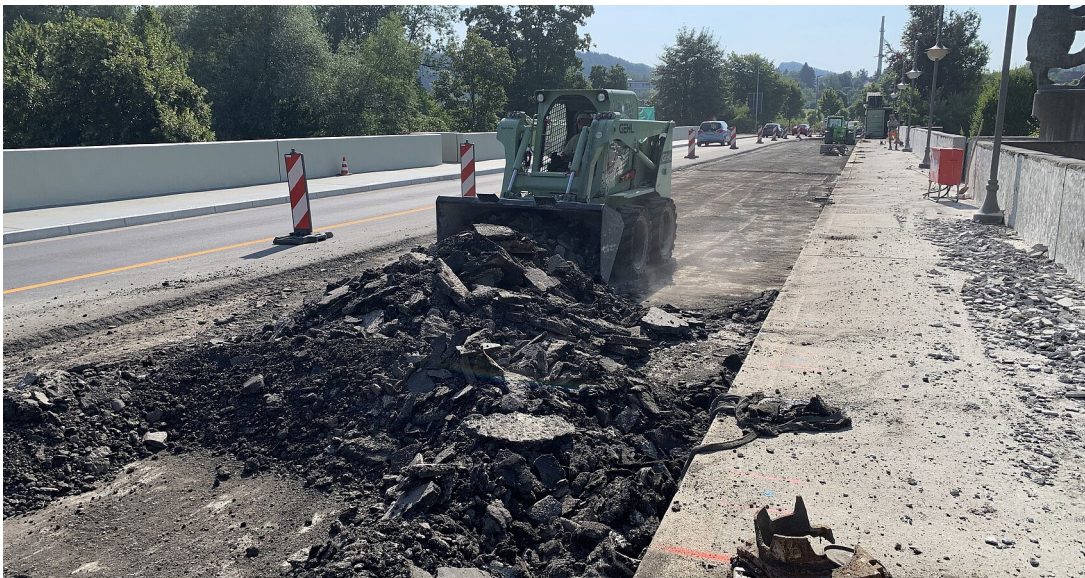
Abbruch der Asphaltfahrbahn auf der Gallusbrücke in Wangen
