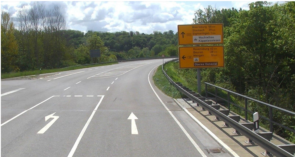
Bundesstraße 32 zwischen dem Kreisverkehr beim Nollhof und Sigmaringen
