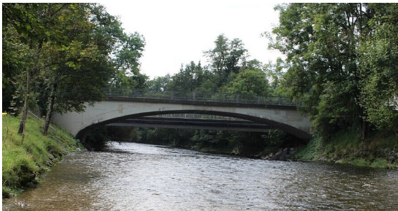
Brücke über die Untere Argen bei Herfatz
