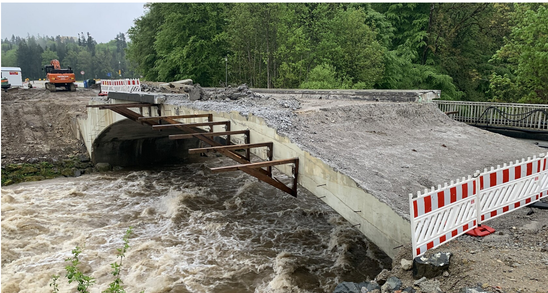
Brücke über die Untere Argen bei Wangen-Herfatz
