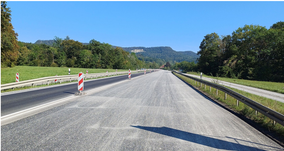
Erneuerung der Fahrbahndecke der B32 bei Hechingen
