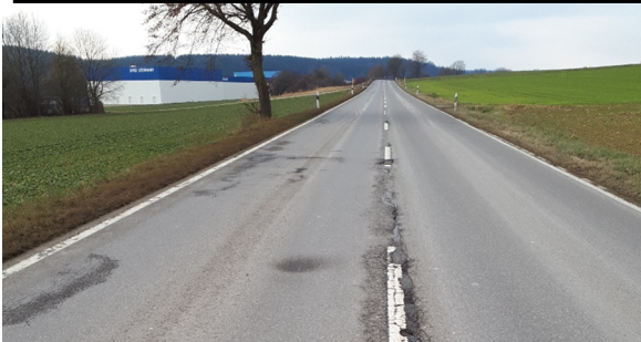
B 32 zwischen Sigmaringendorf und Scheer - Sanierungsabschnitt 2
