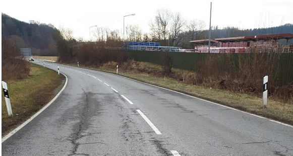
B 32 zwischen Sigmaringen und Sigmaringendorf - Sanierungsabschnitt 1
