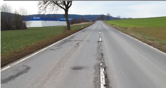
B 32 zwischen Sigmaringendorf und Scheer - Sanierungsabschnitt 2
