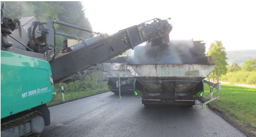
Sanierung der B 32 zwischen Hausen im Killertal und Burladingen
