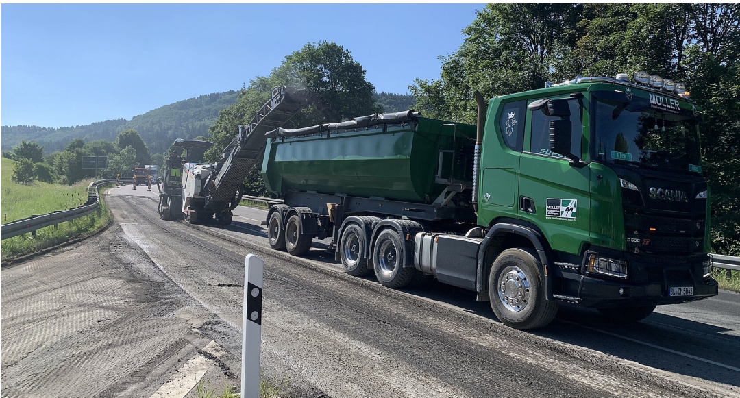
B 463 Fahrbahndeckenerneuerung in der Ortsdurchfahrt von Albstadt-Lautlingen
