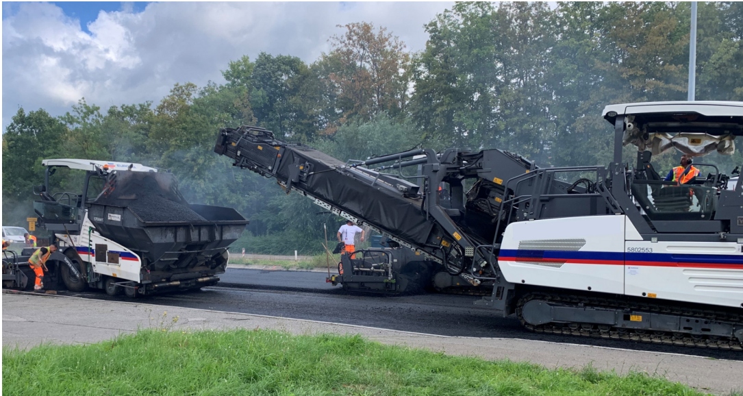
Arbeiten auf der B 464 in Reutlingen zwischen Kreuzung Albstraße/Römerstraße und Pfullingen-Südbahnhof
