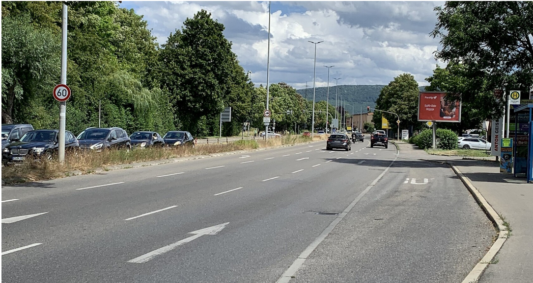
B 464 in Reutlingen zwischen Kreuzung Albstraße/Römerstraße und Pfullingen-Südbahnhof
