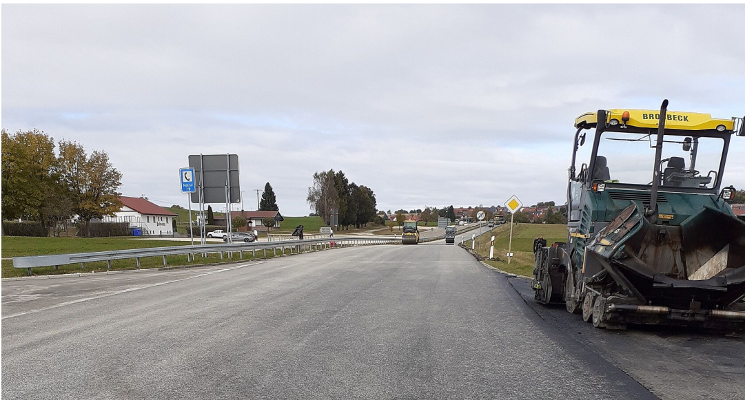
B 465, Fahrbahndeckenerneuerung Anschluss B 28 bis Donnstetten
