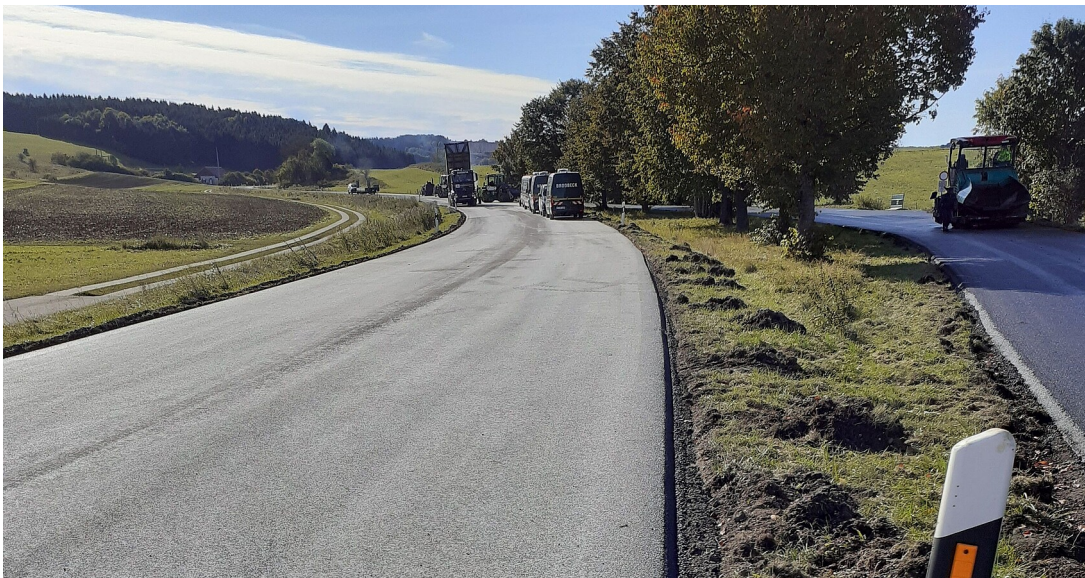
B 465, Fahrbahndeckenerneuerung Anschluss B 28 bis Donnstetten
