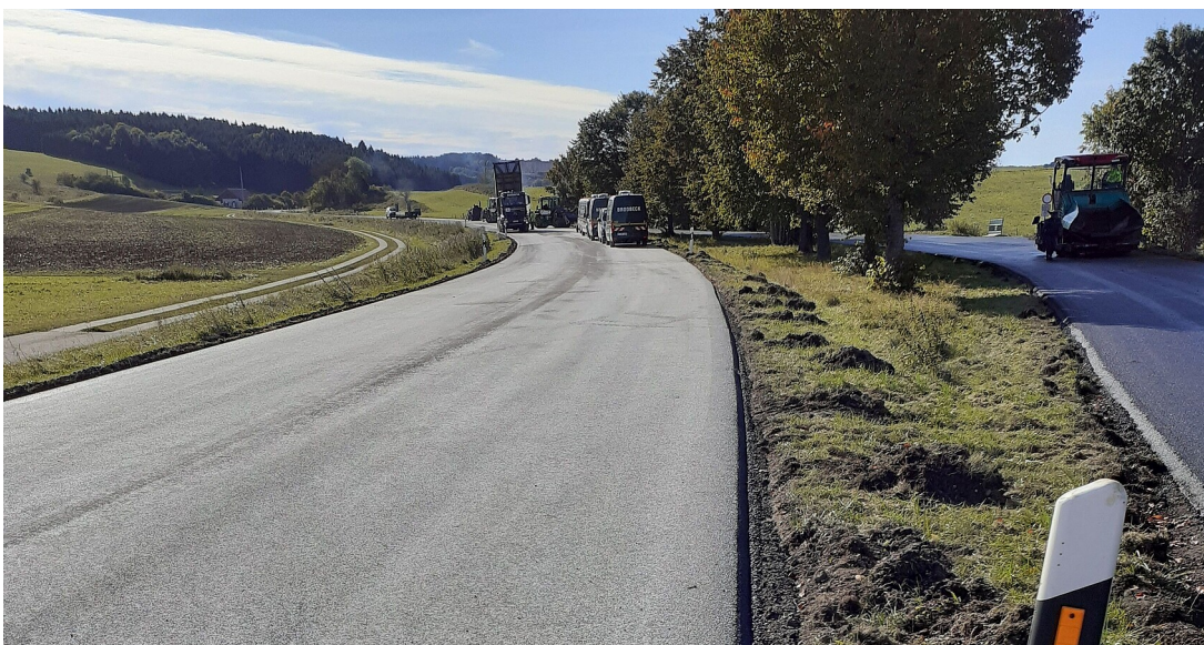
B 465, Fahrbahndeckenerneuerung Anschluss B 28 bis Donnstetten
